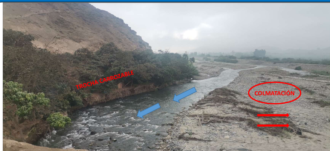
FIGURA N°01: RIO CHANCAY - HUARAL COLMATADO EN EL SECTOR PALPA - SANTA ROSA CON LA PRESENCIA DE: ARENA FINA Y MATERIAL GRANULAR; LAS CUALES DEBEN SER DESPLAZADOS HACIA LA MARGEN IZQUIERDA PARA MANTENER SU SECCIÓN HIDRÁULICA .
