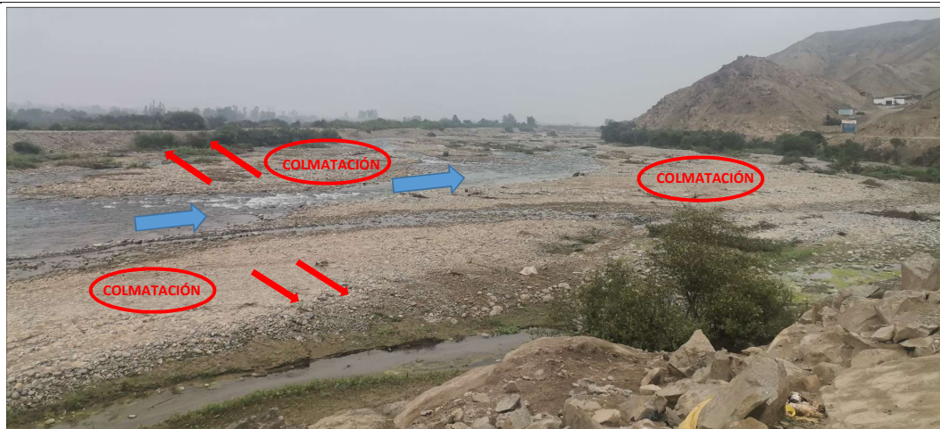
FIGURA N°03: TRAMOS EN EL MARGEN IZQUIERDO DEL RIO CHANCAY - HUARAL CON DEFENSA VIVA Y MATERIAL GRANULAR SUELTO, OCASIONA QUE EL DESBORDAMIENTO DEL CAUCE DEL RIO SEA MAS INMINENTE EN EPOCAS DE AVENIDAS.
