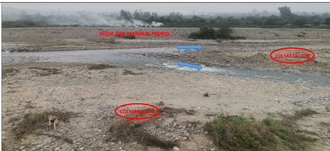
FIGURA N°04: DIQUE EXISTENTE DE MATERIAL PROPIO EN MAL ESTADO EN EL MARGEN IZQUIERDO DEL RIO CHANCAY - HUARAL, ZONA VULNERABLE EN EPOCAS DE AVENIDAS.
