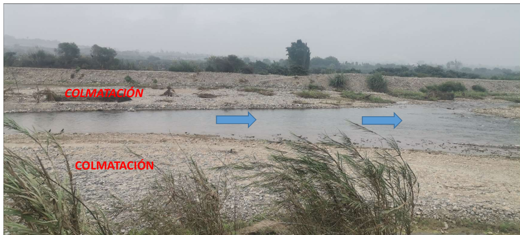
FIGURA N°02: MARGEN IZQUIERDA DEL RIO CHANCAY - HUARAL CON DIQUE DE PROTECCIÓN EN MAL ESTADO, POR TAL MOTIVO ES VULNERABLE A LAS VELOCIDADES EROSIVAS DEL RIO PRODUCIENDO DESBORDES DEL CAUCE DEL RIO, EN EL SECTOR PALPA - SANTA ROSA DEL DISTRITO DE HUARAL - AUCALLAMA
